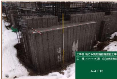
「灰・粗大処理エリア」の基礎工事完了後、出来形確認を行っています。
