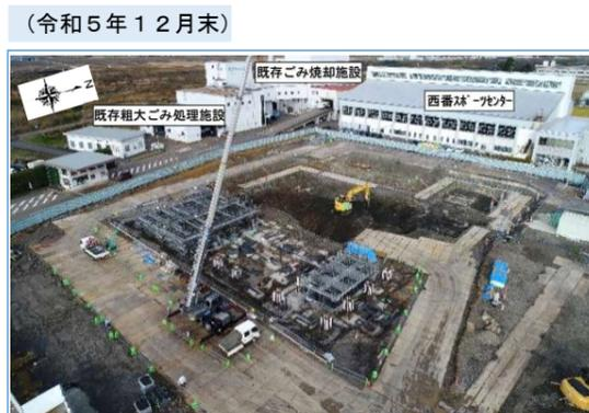
(令和5年12月末) ケビン・炉室・灰・粗大処理エリア基礎工事中、地階部掘削工事中
