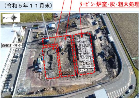
(令和5年11月末) ケビン・炉室・灰・粗大処理エリア地業完了、地階部掘削工事中
