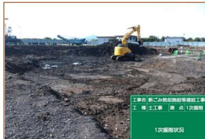
「蒸気タービン室、焼却炉室、灰処理、粗大処理エリア」の基礎工事を行うため計画の深さまで土を掘削しました。
