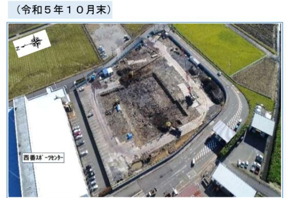
(令和5年10月末) 杭工事完了後、掘削工事中
